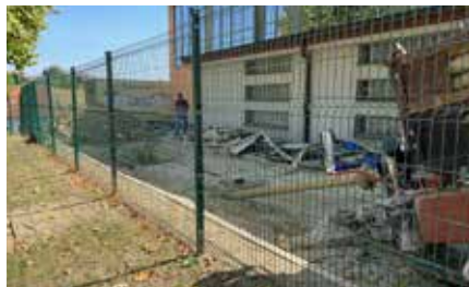
Novi elektro priključek iz Gallusove ulice do OŠ Šmarje pri Jelšah. Foto: arhiv občine
